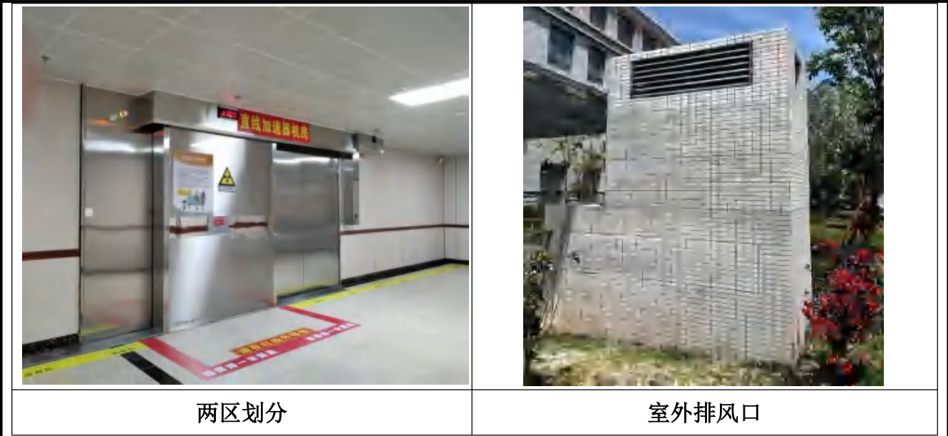
图 3-9 直加机房现场照片
