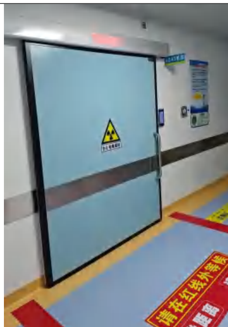
DSA 手术室患者进出防护门 (工作状态指示灯、电离辐射警示标志)
