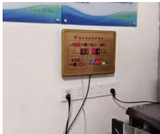
固定式剂量报警仪（控制室内）
